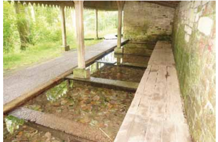
Kristallklares Wasser in den alten Becken vom Waschhaus.
